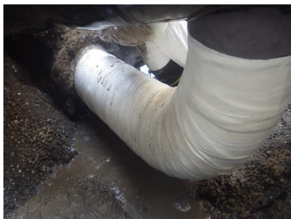
④防錆・防食・保護・補強の目的で、ブチルロールの上から、マホータイ(特殊レジン含浸グラスファイバーテープ)を巻き、硬化剤の水を含ませ、巻いた方向と同じ方向に絞る作業を行う
