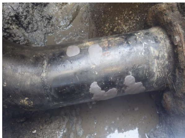
②まず、凹部分にオリスチール(金属粉入りエポキシパテ)を押し付けるように充填し、補強する
