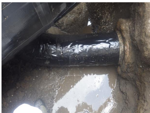
③次に、マホータイの下地としてブチルロール(下地用ブチルゴム)を管全体に貼る
