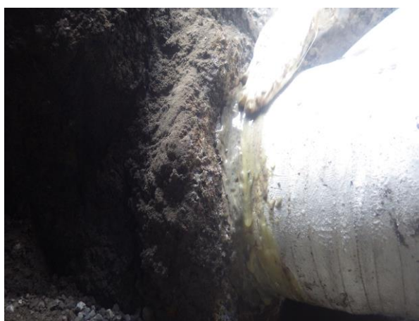
⑤マホータイが巻ききれないフランジとの際の部分は、防食、保護の目的で、先ずオリスチールを充填し、その上にオリシール(液体エポキシレジン)を塗布する
