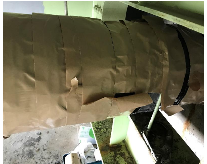
②施工中 最初に、ウェスで拭って取れる錆を取り除き、管全体にブチルロール(下地用ブチルゴム)を貼付け、管の凹凸を埋める。
