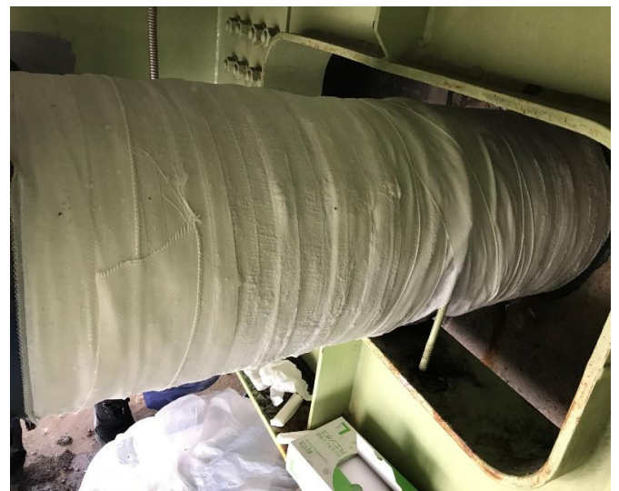
④最後に、防食補強を兼ね備えたパイプの延命補強材マホータイ(特殊レジン含浸グラスファイバーテープ)を巻き付け、緩みを解消する目的で硬化剤の水を手袋に含ませ、巻いた方向と同じ方向へと撫で付ける様に良く絞り施工終了。
