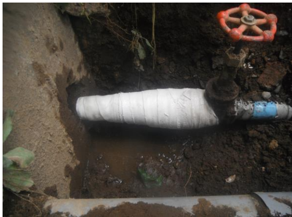
⑨最後に、パイプの延命補強材マホータイ(特殊レジン含浸グラスファイバーテープ)を巻き、補強する。
