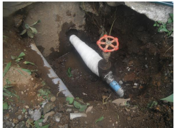
⑩施工後 マホータイを巻き終わり後、硬化剤の水を含ませながら、巻いた方向と同じ方向に絞り作業を終了する。
