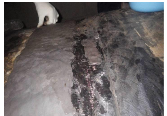
⑥続けて、10mmの穴には、オリスチールを充填し埋める。
