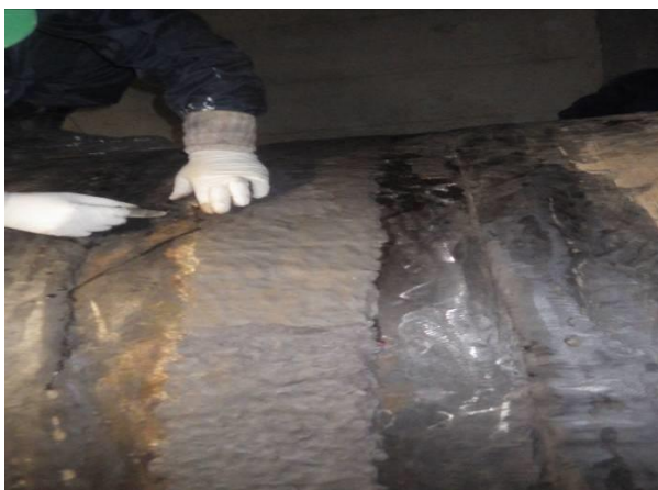
⑤施工当日 まず亀裂の部分には、穴を塞ぐ目的と強度をつける為、特注ステンメッシュ(大きい傷穴用補助部品)にオリスチール(金属粉入りエポキシパテ)を挟むように付け、亀裂部に押し付けるように充填する。
