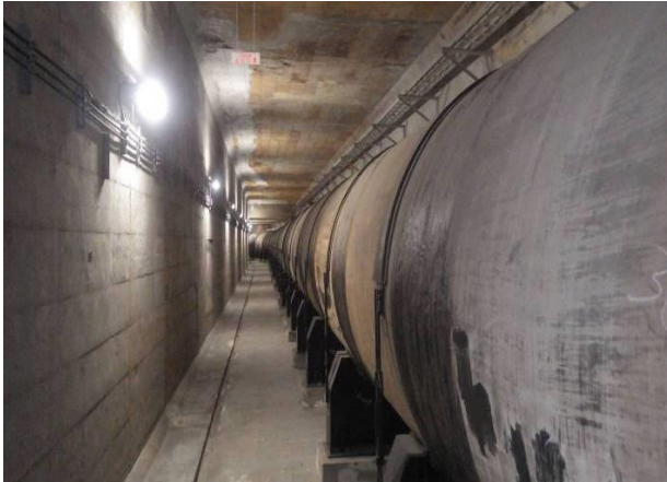
①12/6調査日 高さ5m、幅約3mの地下共同溝内1800Aの下水道管
