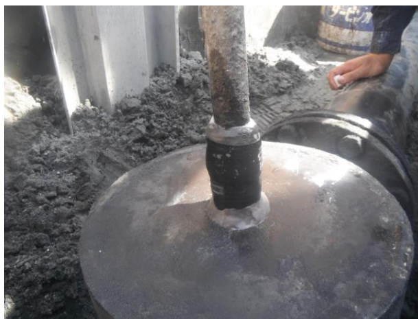
③仮止め作業 オリスチール(金属粉入りエポキシパテ)を傷口に当て、オリステープ(仮止め用テープ)を傷の真上で強く引っ張りながら巻く。
