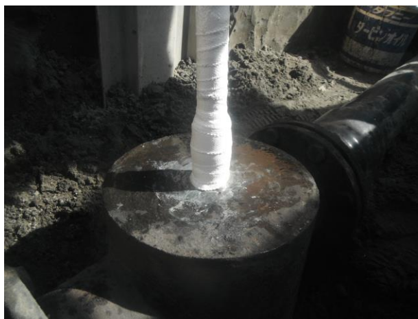
⑤マホータイ巻付け作業 仮止め、下地処理作業終了後、最後にパイプの延命補強材マホータイ(特殊レジン含浸グラスファイバーテープ)を全体に巻く。
