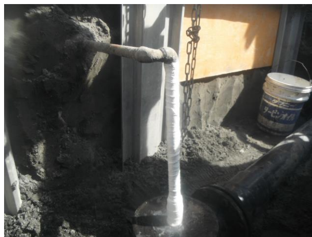
⑥漏洩部補修・全体補強終了 マホータイ巻付け後、硬化剤の水を含ませ、巻いた方向と同じ方向に絞る作業を行い終了。
