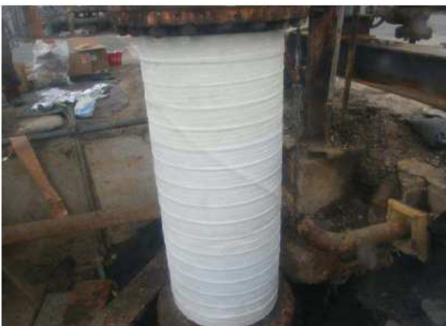
⑤1.5m全てを巻き、1本目の施工完了。
