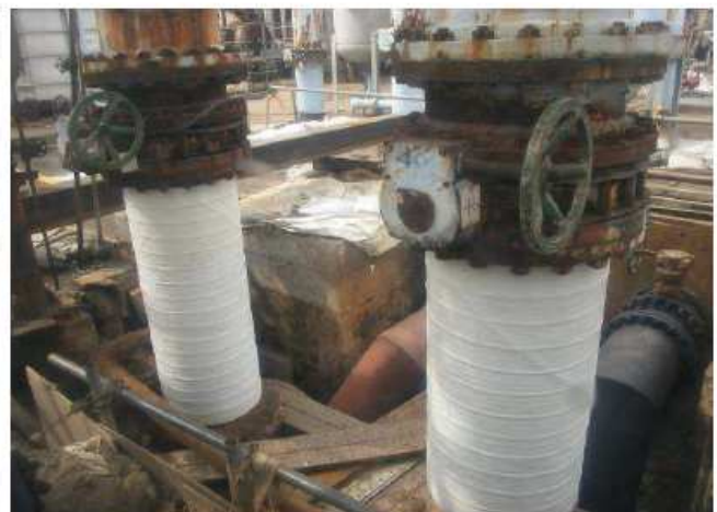
⑥2本目も同様に作業して頂き、施工完了。
