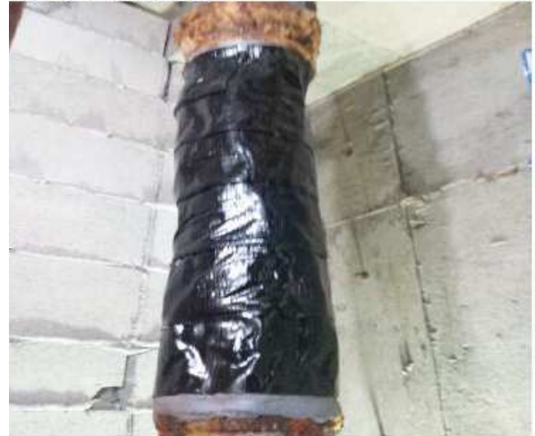
②ケレン後、錆の凹凸を埋める為 まずプチルロールを円周上に貼り付ける。
