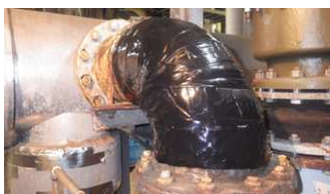
塞ぐブチルロール (幅広長尺のラバーパッチ)
