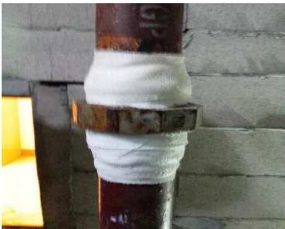
⑤次に③の施工と同様にマホータイを巻く。 マホータイは空気中の水分で自然に硬化する為 次の作業に移動する。
