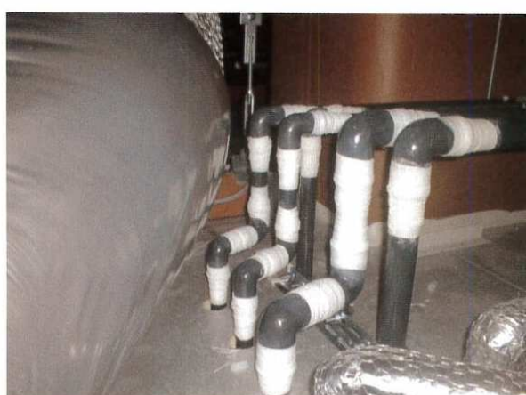
⑥配管継手部補強完了。
