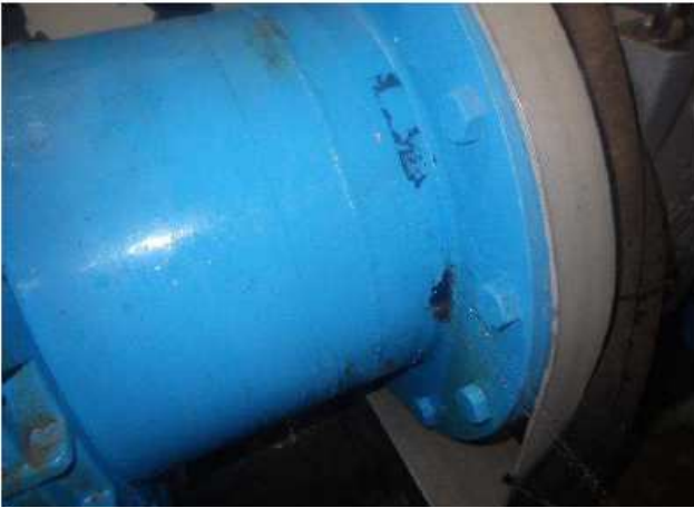
①以前に施工されていたテープを外し、漏水状態を確認する。 フランジ際の溶接部から漏水しているのを確認する。
