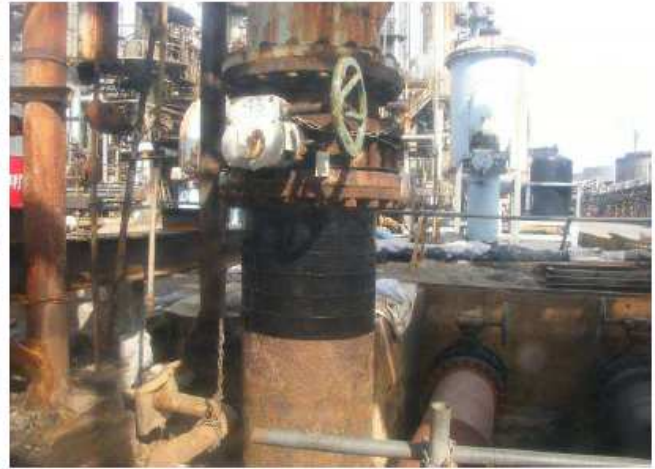
②最初に、施工業者様1名・弊社2名の3名で施工を行う。まずマホータイの下地として、フチルロールを配管全体に貼り付け、配管の凹凸を埋める。
