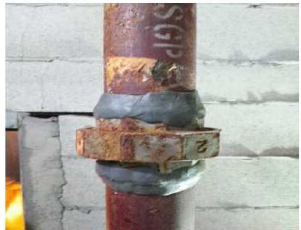
④継手段差部もケレンを行う。 まず補強の目的でオリスチールを充填する。
