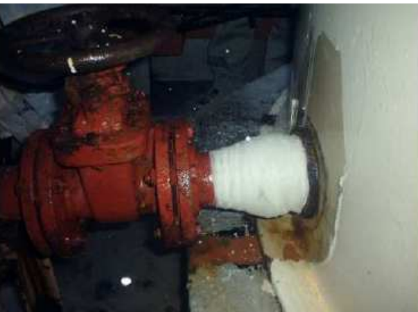
⑤マホータイを巻き終わり後、硬化剤になる水の代わりにお湯をかけ、巻いた方向と同じ方向によく絞る施工完了。今回は雪が降る悪天候の中だが、マホータイは水が硬化剤なので問題なく施工が可能。
