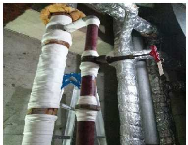
⑥他箇所も同様に施工を行い、作業を終了する。
