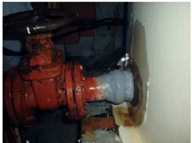
④オリステープで完全止水後、次にマホータイを巻くが今回はパイプの腐食が酷い為、先にオリスチールを充填する。
