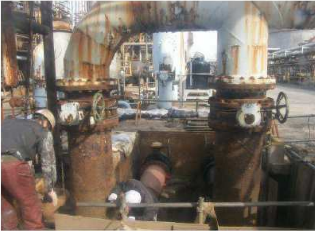
①施工開始前に、施工業者様に配管のケレン（浮いた錆や汚れを落とす）を行って頂く。
