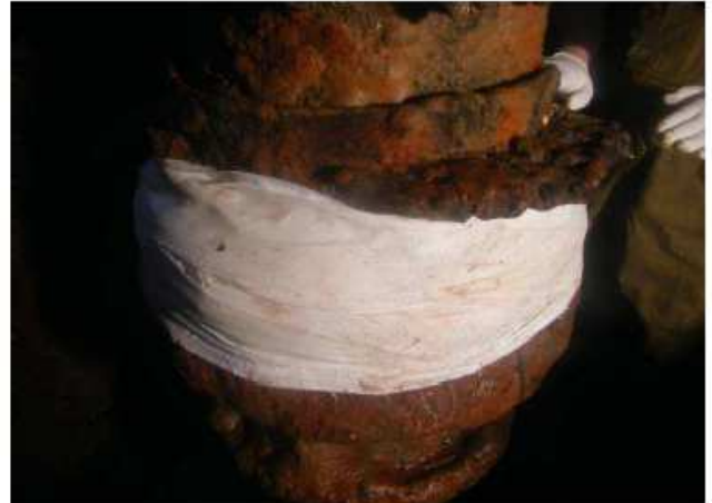
⑥下地処理後、防食・補強を兼ね備えたマホータイを巻き、巻いた方向と同じ方向によく絞る。
