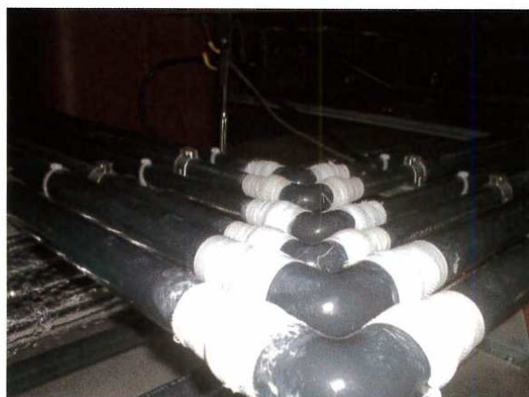
④ブチルロールの上からマホータイを巻く。
