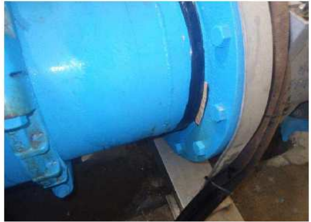
②まず、傷口を完全に覆える大きさに切ったプチルロールを貼り付け、その上にオリステープを巻き始める。
