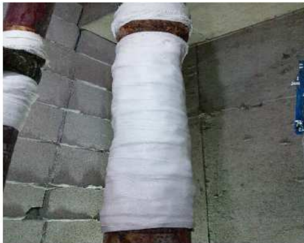
③次に、防食・補強を兼ね備えた延命補強材 マホータイを巻く。巻き終わりに後、硬化剤の水を含ませ、 巻いた方向に撫で付けるようによく絞る。
