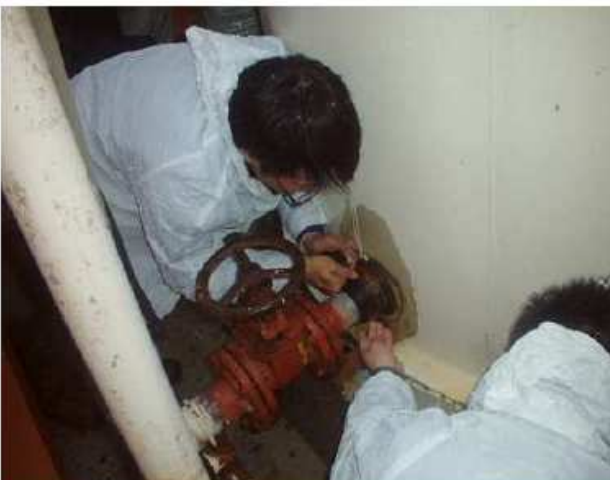
③プチルロールを傷口が隠れる大きさに切り、傷口に押し当てる。その上からオリステープを傷口の真上に一点集中で強く引っ張りながら巻き完全止水する。
