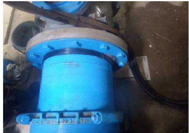
④オリステープを最後まで強く引っ張りながら巻き、この段階で漏水が止まっている事を確認する。
