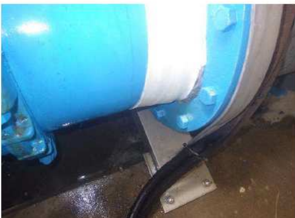
⑤ステンメッシュを貼り付け後、錆の凹凸が激しい為、隙間を埋める目的でオリシールを塗る。 (もう1箇所も同様に施工する。)
