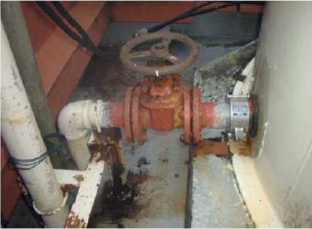
①以前、補修金具にて施工されたようだが完全止水が出来ていない為「マホータイ・オリステープ」で施工させて頂く。
