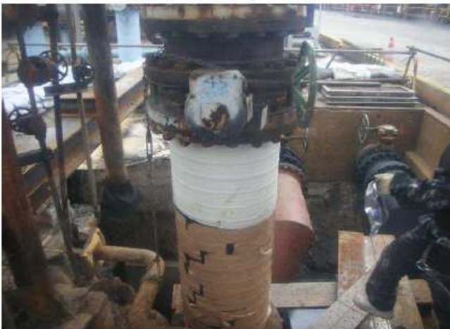
③次に、パイプの延命の為、防錆・防食・保護・補強を兼ね備えたマホータイを巻き、硬化剤である水をかけマホータイの緩み弛みを解消する目的で、巻いた方向と同じ方向に撫で付けるようにしてよく絞る。同様に、施工業者様にフチルロールを貼りつけて頂く。
