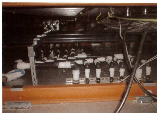
⑤マホータイを巻いた方向と同じ方向によく絞り、補強完了。
