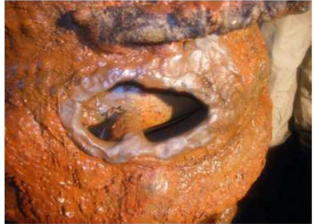
②まず、施工箇所を可能な限りケレン作業を行い、錆の凹凸や汚れを落とす。ケレン後、これ以上穴を大きくさせない為、ふちの部分にオリスチールを挟み込む様に貼り付け補強する。
