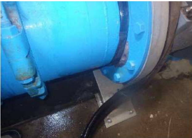
③オリステープは、傷口の上を一点集中で可能な限り強く引っ張りながら巻く。 (※傷口幹部を押さえられない場合、許容範囲外)
